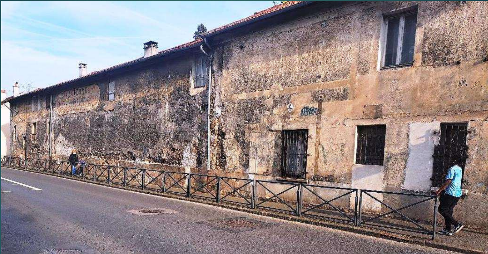
Au 67 route des Gardes, un témoignage du passé rural de Meudon: une ancienne ferme devenue auberge " La Rose" .
